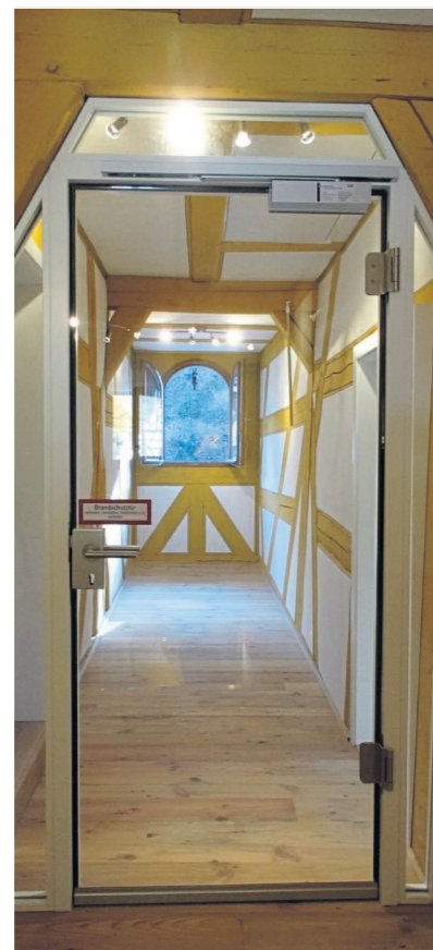
Geschichte und Moderne: Die Brandschutztür aus Glas passt perfekt zu den Fachwerkbalken.
