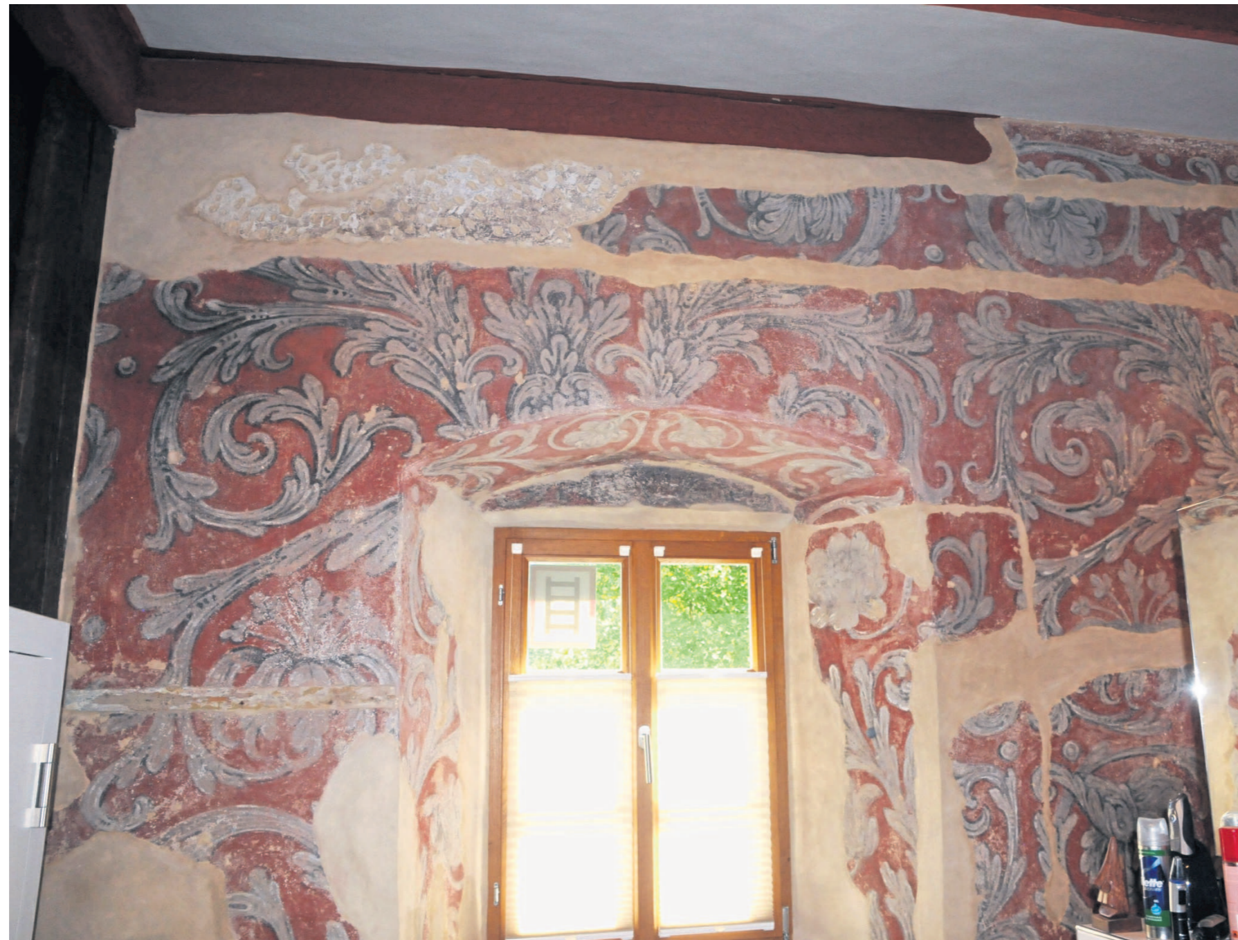
Die erhaltenen Rocaille-Malereien befinden sich um 1. Obergeschoß. Vermutlich wurde um ca. 1720 nur ein Raum mit dieser aufwendigen Wandmalerei ausgestattet. Er dient heute als Badezimmer. Die durch Baumaßnahmen verursachten Schlitze wurden bewusst beibehalten und nur beigeputzt. Bild: Gebhardt
