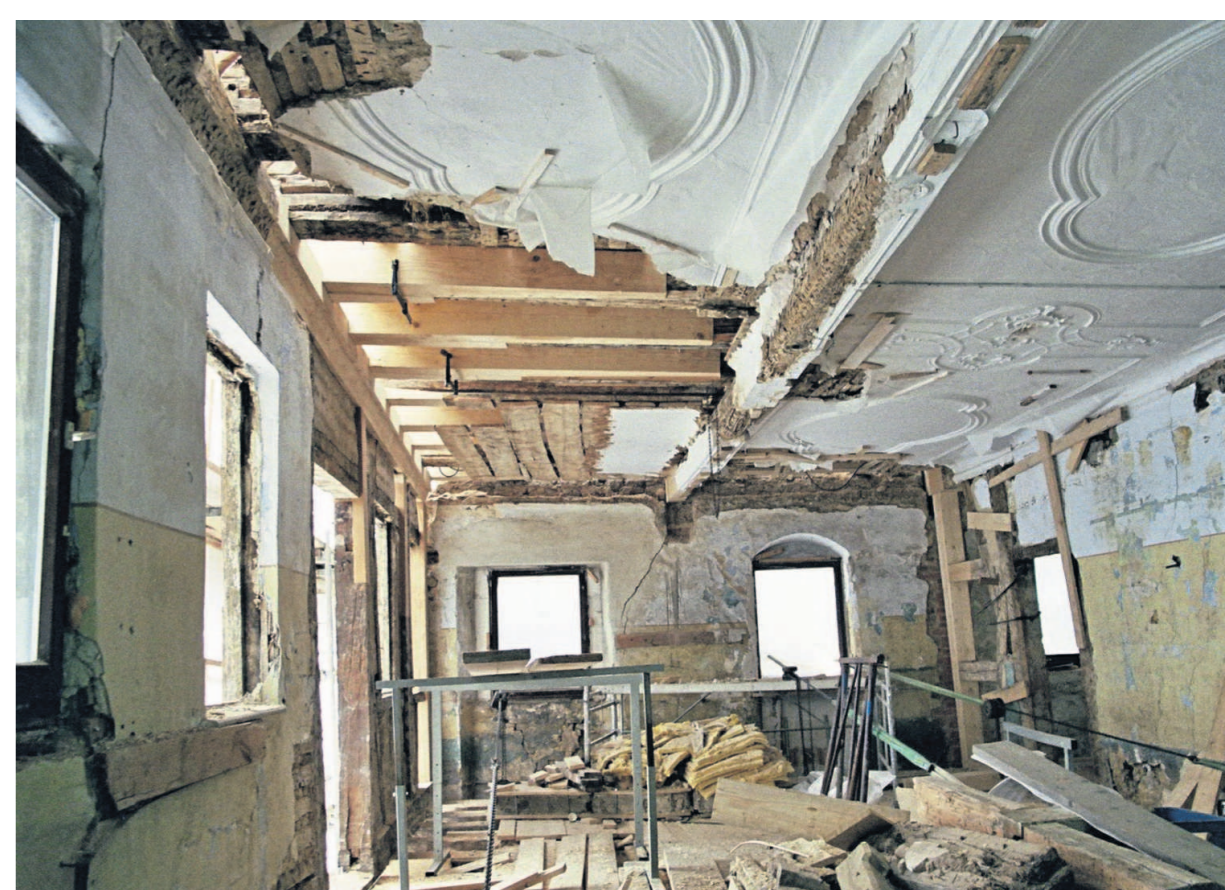
In diesem Zustand befand sich der Stucksaal vor der Restaurierung.
