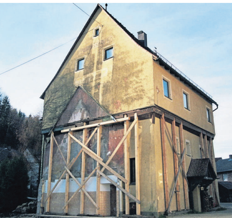
Nach Abbruch des Nebengebäudes musste das alte Haus erst einmal gestützt und wieder stabilisiert werden. Bilder: Knorren (3)
